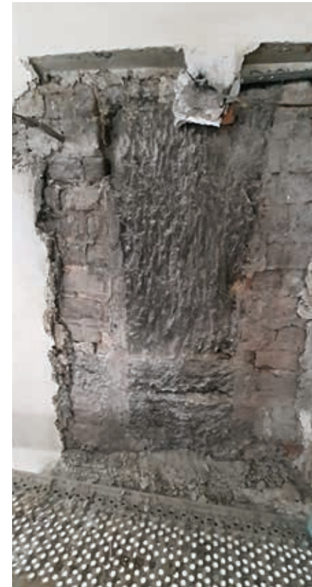
Otesané náběhy žeber klenby severní lodi po odstranění dřevěných hlavic na prvním severním pilíři (foto D. Halátek, 2019).
