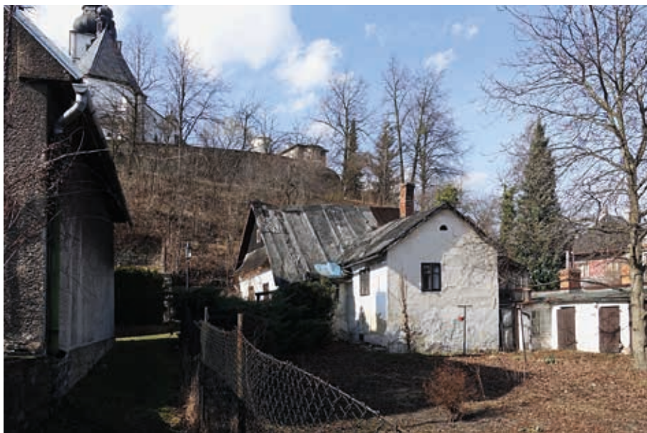
Pohled na dům čp. 383 od jihovýchodu; zachycena jak východní přístavba vedlejší světnice, tak rovněž část severovýchodní přístavby lemující severní hranici pozemku zahrady (foto P. Huvar, březen 2017).
