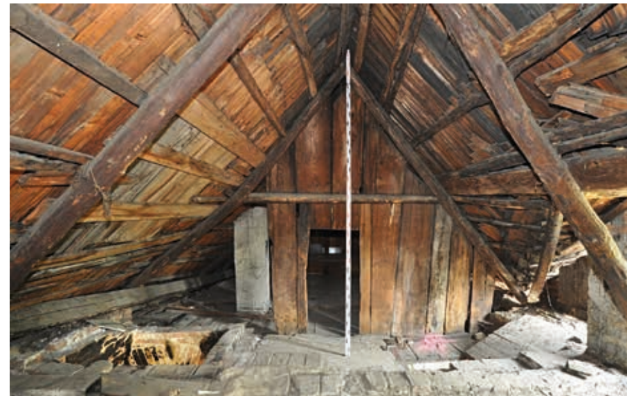
Pohled na bedněnou stěnu v podkroví domu čp. 383; vlevo v podlaze otvor po vyústění průlezného komína nad černou kuchyní (foto D. Alterová, srpen 2017).
