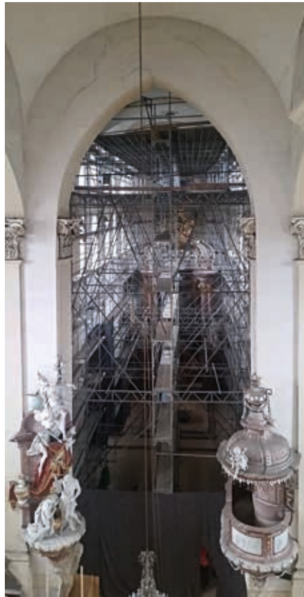
Lešení pokrylo opravu každý kousek stěn také v interiéru kostela (foto D. Halátek, 2020).
