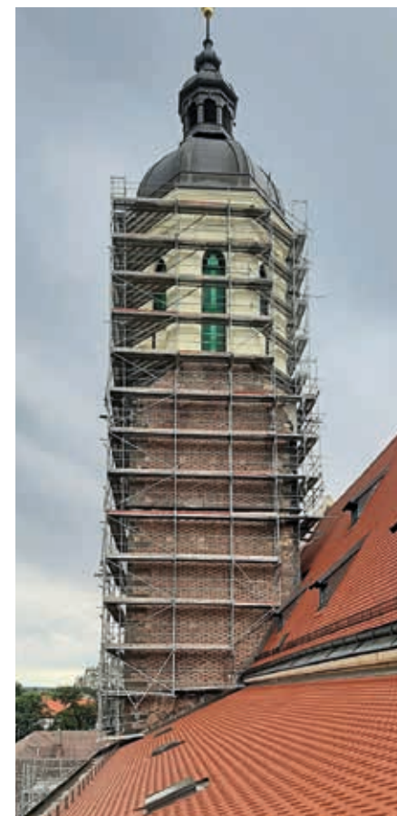
Lešení pokrylo opravdu každý kousek fasády exteriéru kostela (foto D. Halátek, 2020).
