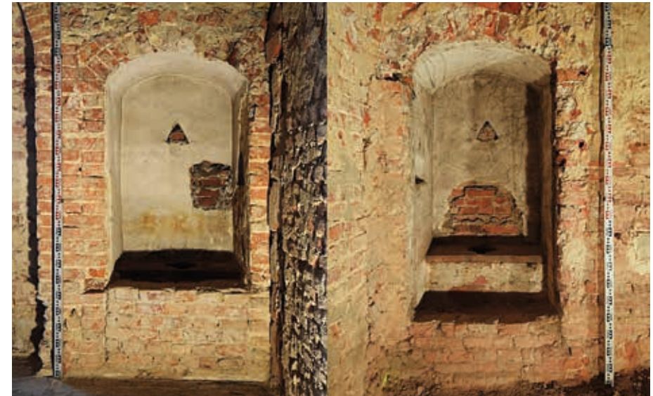
Dva nejlépe zachované odkryté renesanční záchody v místnostech č. 205 a 208 prvního patra zámku (foto D. Alterová, duben 2018).
