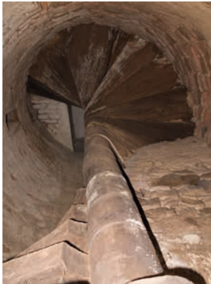
Vřetenové schodiště v severní obranné věži s dubovým nosným sloupem, vročeným do období kolem roku 1436; nálezořav stav (foto P. Kerlin, 2018, uloženo v Archivu NPÚ, SZ Raduň).
