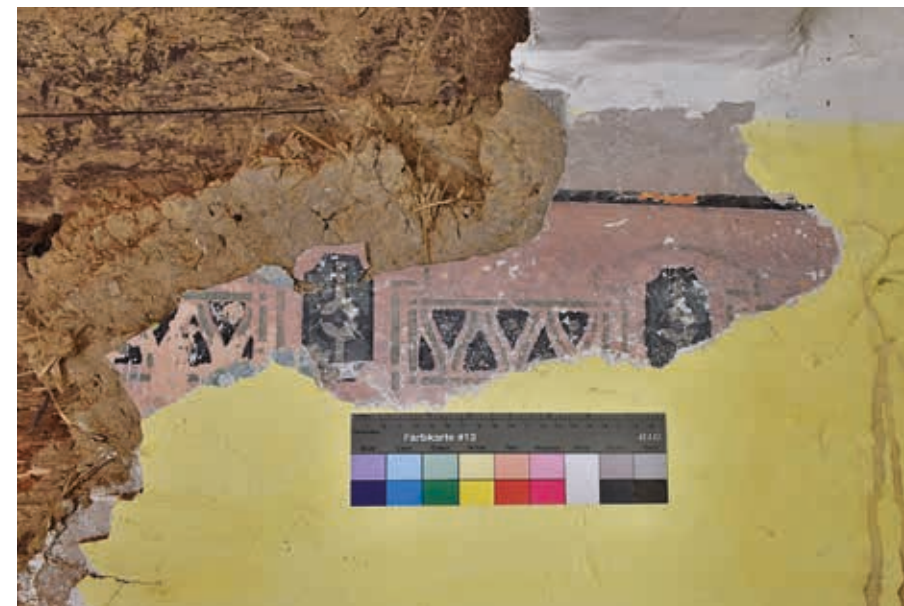
Pozůstatek šablonové výmalby na stěně velké jižní světnice domu čp. 383 (foto J. Koudelová, srpen 2017).
