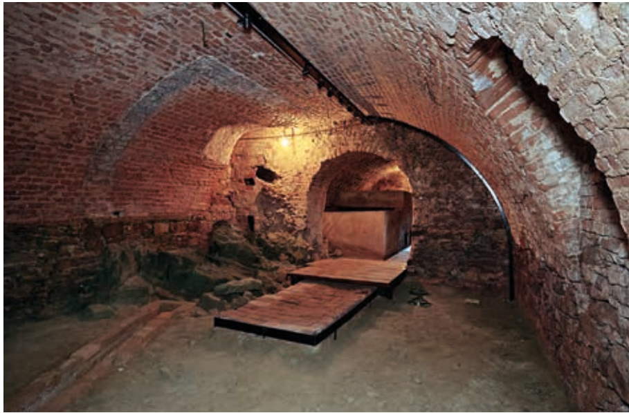
Místnost příslušná k nejstarší části jižního suterénu s pohledem do míst někdejší otopné komory z první třetiny 19. století; stav po rekonstrukci (foto P. Kerlin, 2018, uloženo v Archivu NPÚ, SZ Raduň).
