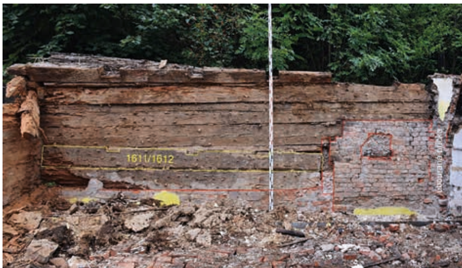
Pohled na západní stěnu velké jižní světnice domu čp. 383 s vyznačením nálezových situací včetně nejstaršího datovaného trámu 1611/1612 (foto J. Koudelová, srpen 2017).
