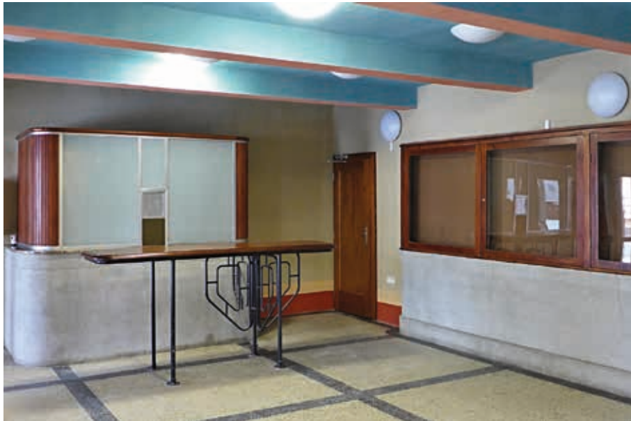
Kino Panorama ve Vítkově, interiér haly v 1. PP po obnově výmalby 2018 (foto H. Pavelková, 2019).
