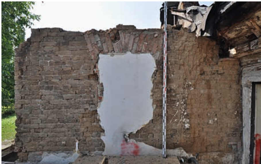
Pohled na severní obvodovou zeď přístavby východní světnice domu čp. 383 se zazděným oknem (foto D. Alterová, srpen 2017).
