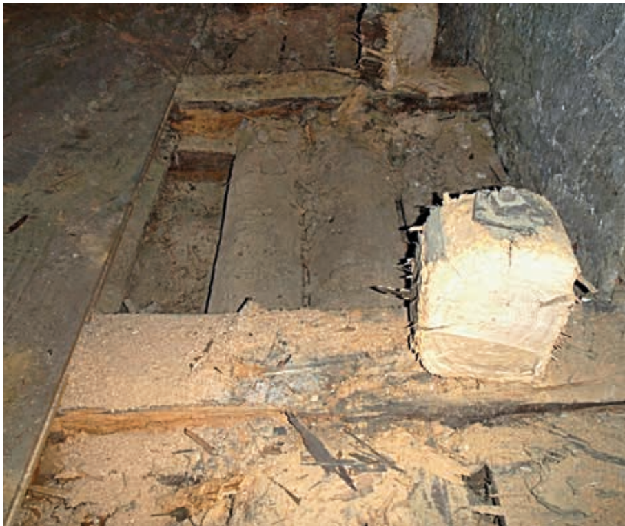
Fara v Kravařích, podkroví, strop s povalovými záklopy (foto R. Winkler, 2012).
