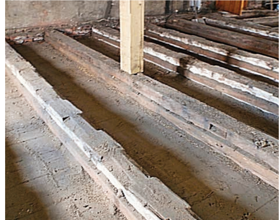
Fara v Kravařích, podkroví, stropní trámy původně pohledového stropu s dlaby pro desky překládaného záklopu (foto R. Winkler, 2012).
