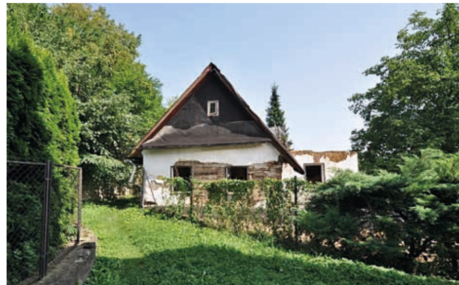
Pohled na dům čp. 383 od jihu (foto D. Alterová, srpen 2017).
