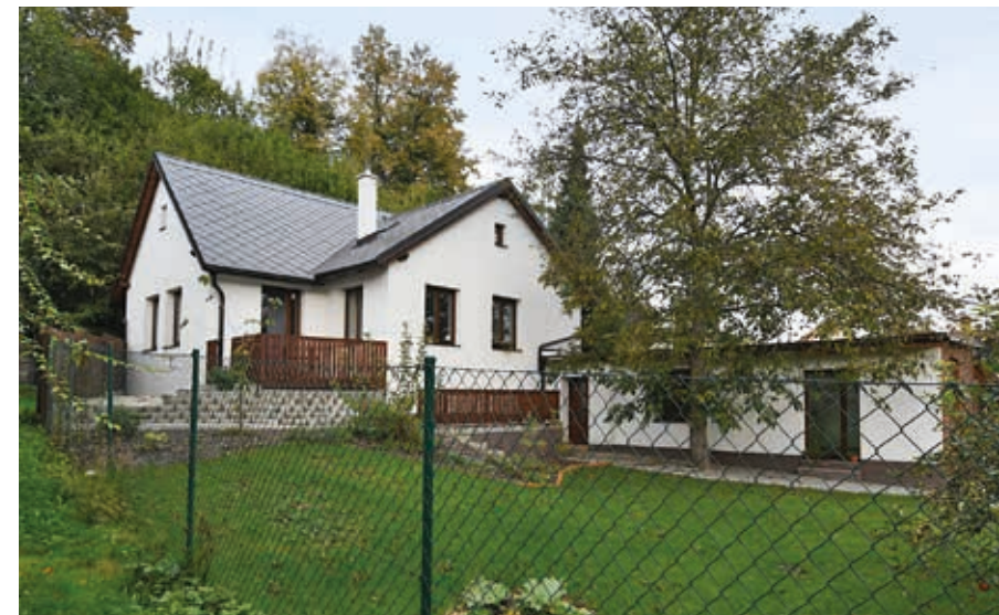
Pohled na novostavbu rodinného domu čp. 383 od jihovýchodu (foto J. Koudelová, 2019).
