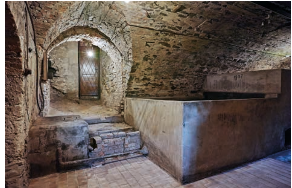
Místnost příslušná k nejstarší části jižního suterénu s pohledem k jímači vody z rybníka Vrchní, zřízenému v roce 1934, stav po rekonstrukci (foto P. Kerlin, 2018, uloženo v Archivu NPÚ, SZ Raduň).
