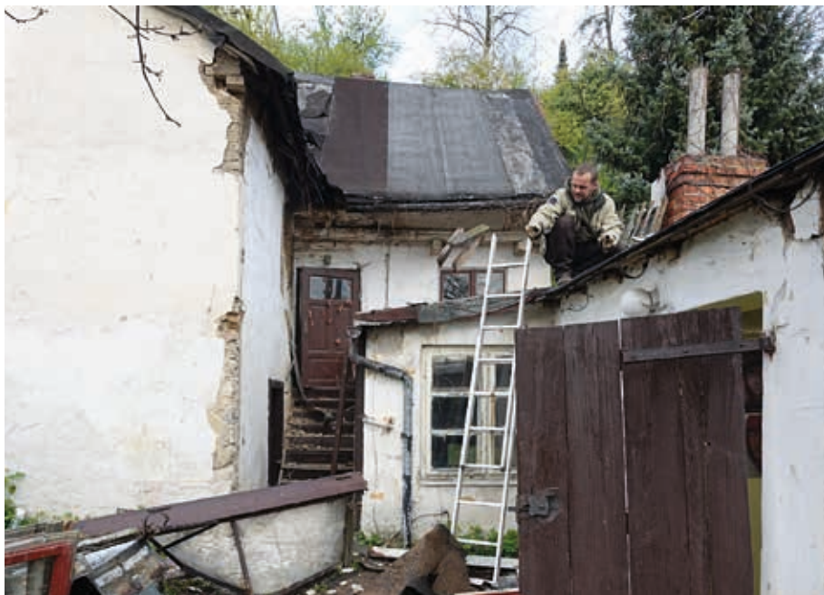
Pohled od východu na odstojenou konstrukci zadní dřevěné verandy domu čp. 383 a na venkovní schodiště, které veranda kryla; v popředí ještě stojící severovýchodní přístavba (foto P. Huvar, únor 2017).
