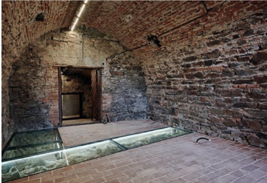
Suterénní místnost, přiřazená ke starším sklepům během renesanční přestavby po roce 1550; pod úroveň podlahy zůstal zachován průběh středověké ohradní zdi; stav po rekonstrukci (foto P. Kerlin, 2018, uloženo v Archivu NPÚ, SZ Raduň).
