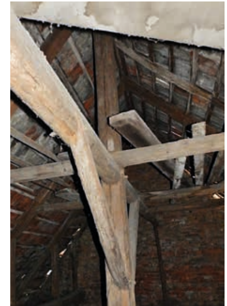
Středový věšák v severovýchodní části krovu výminku v Petřvaldiku (foto A. Richterová, 2019).
