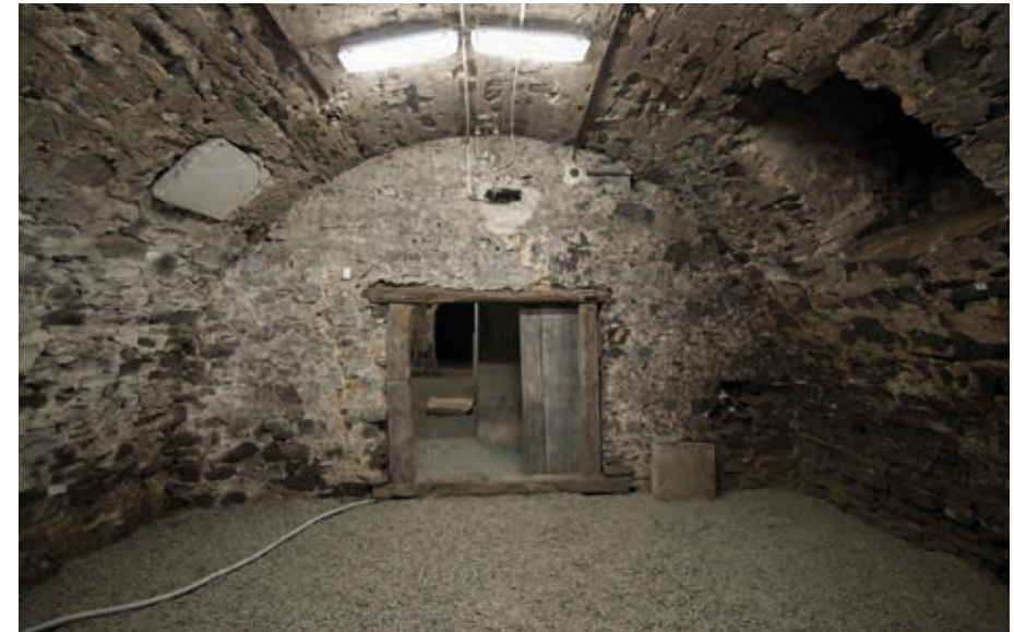
Průhled dvěma z nejstarších sklepů jižního suterénu k západu, se zárubní a překladem z období mezi 1533 až 1534; náleznový stav před zahájením rekonstrukce (foto P. Kerlin, 2017, uloženo v Archivu NPÚ, SZ Raduň).
