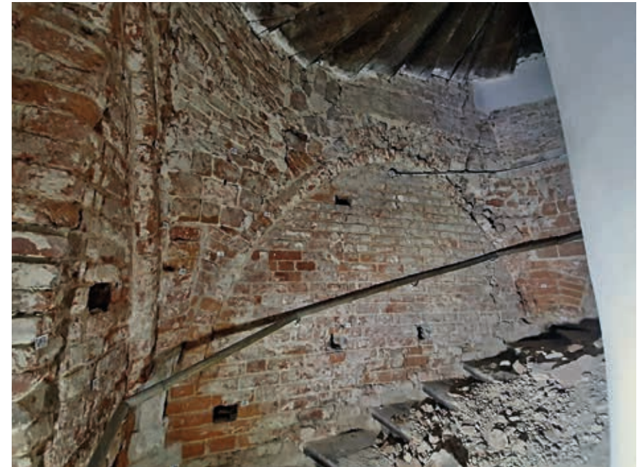
Severní stěna podvěží severní věže po otlučení nesoudržných omítek (foto D. Halátek, 2019).
