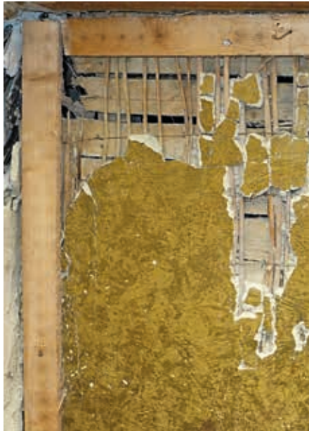
Kino Panorama ve Vítkově, detail původní výmalby stěn a malých podhledů na balkoně kinosálu – hnědý podklad se zlatým válečkem (foto Hana Pavelková, 2018).
