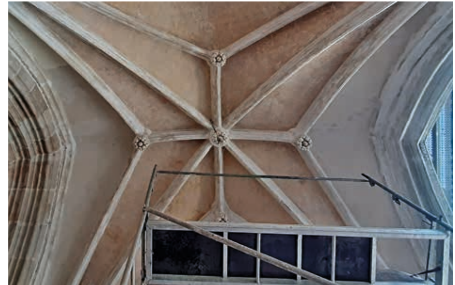
Strop západní předsíně před dokončením restaurování (foto D. Halátek, 2020).
