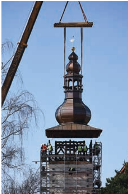
Osazování nové bání na zámeckou věž (foto J. Koudelová, březen 2019).
