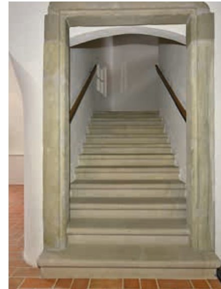
Pohled na část rekonstruovaného kamenného schodiště v interiéru zámku (foto J. Koudelová, 2020).
