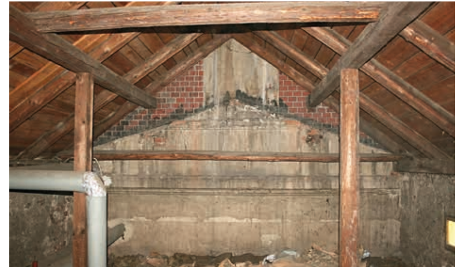
Fara v Kravařích, podkroví západního přístavku, skladba průčelí z doby před novogotickou úpravou (foto L. Augustinková, 2009).
